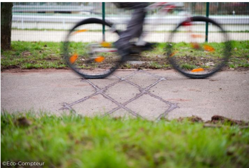
Figur 35 Frästa slingsensorer för detektering av passerande cyklar och elsparkcyklar. Källa: Amparo.
