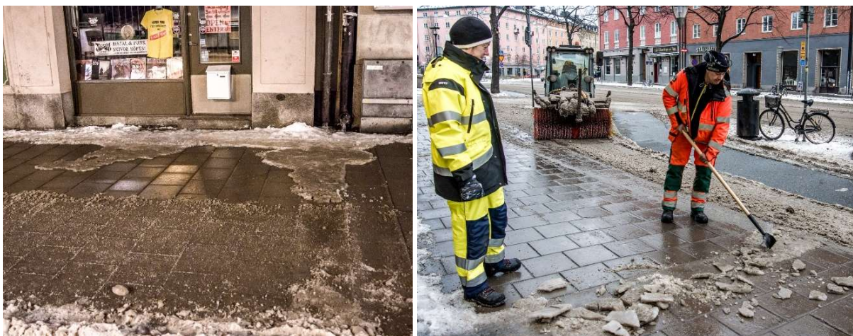
Figur 22. Isbildning i anslutning till stuprör på trottoaren längs S:t Eriksgatan (till vänster) som kräver manuellt arbete för att råda bot på (till höger).
