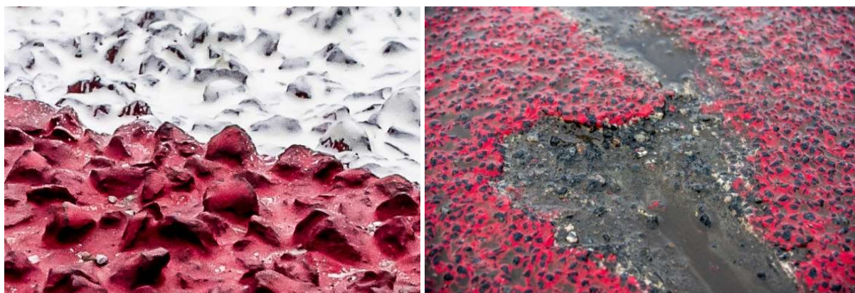
Figur 38. Cykelpassagen i Västberga med en röd massa innehållande Bauxit. Nedre bilden till höger visar plogskador på ytan.
