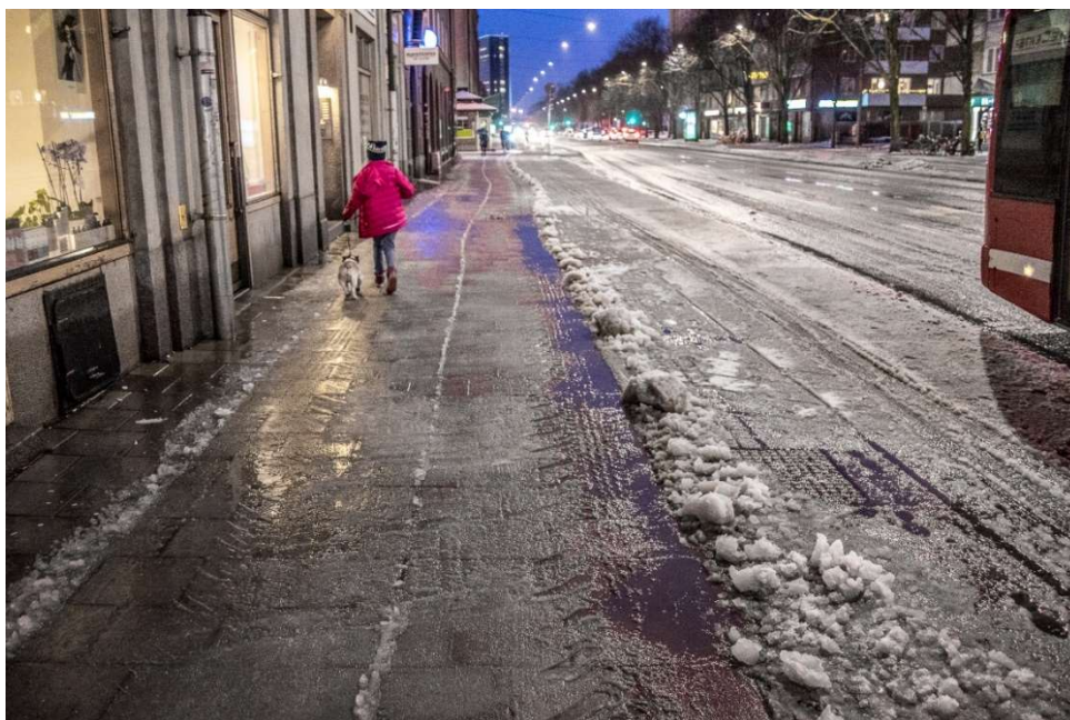
Figur 17. Rester av snömodd efter plogning på trottoaren längs Sveavägen, den 24 januari 2018. Innan plogningen var det ungefär 1 cm snömodd på ytan och efter plogningen återstår ca 0,3 cm.
