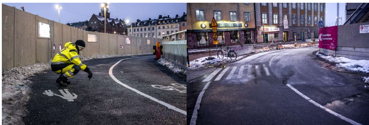
Figur 28. Gång- och cykelvägen vid Slussen. Intorkat salt nere i kurvan (till höger) och torr barmark utan synligt salt högre upp i backen (till vänster).
