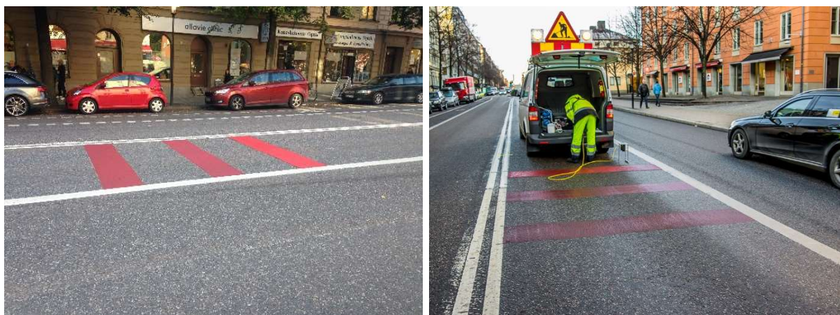
Figur 29. Tre fält med olika typer av rödfärgade massor målade på Fleminggatan. Fotot är taget den 16 november 2017.
