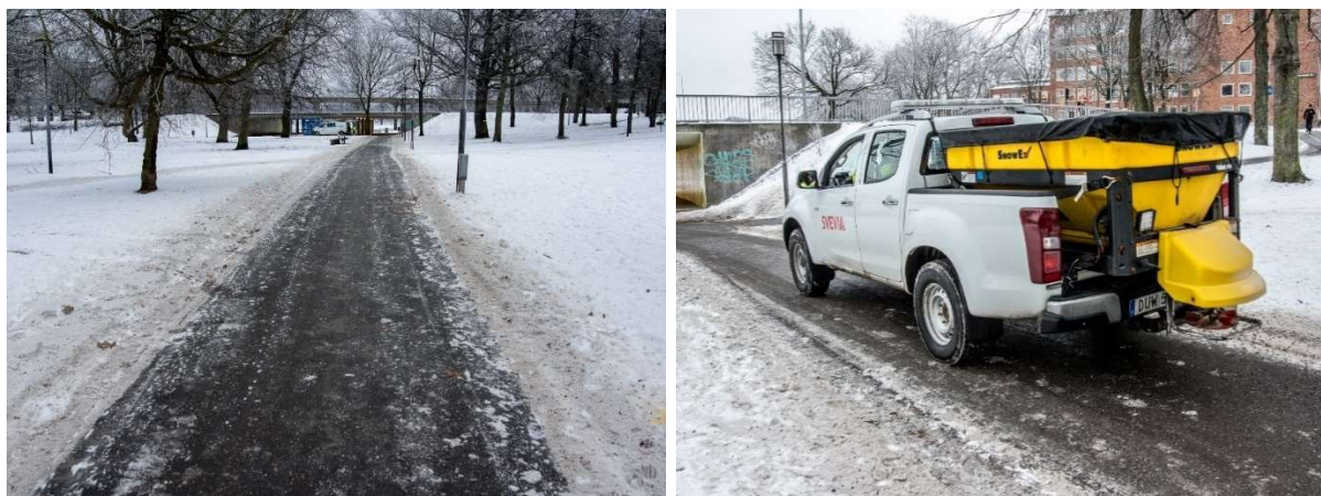
Figur 7. Gångbanan efter borstning (till vänster) med efterföljande sandning (till höger), vid lunchtid den 22 januari, 2018.
