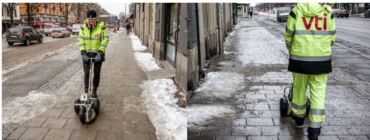
Figur 24. Trottoaren på Sveavägen med lös snö den 5 mars (till vänster) och med våt barmark men isbildning vid stuprörsrännorna den 7 mars (till höger).
