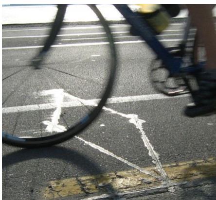
Figur 2: Cyklar räknas automatiskt av slingor som ligger nedfrästa i asfalten.
