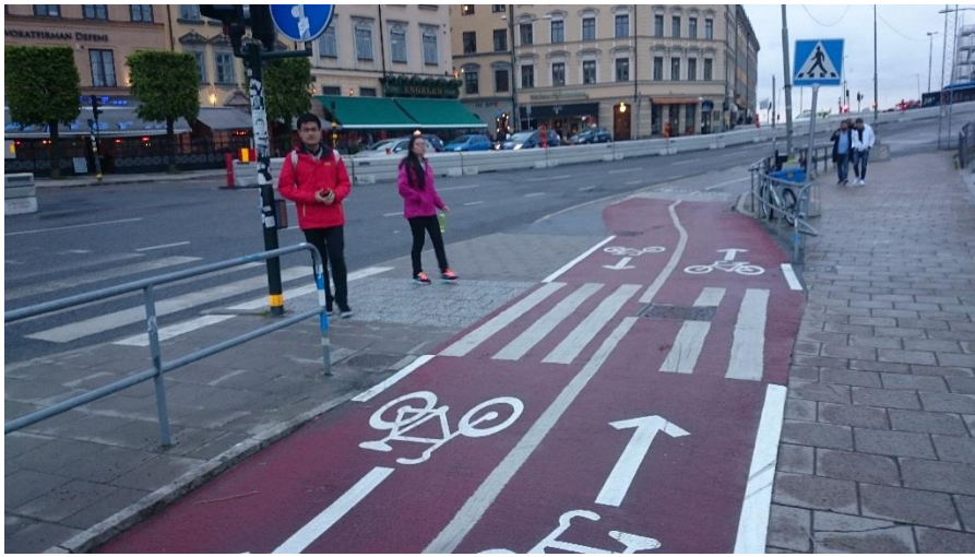
Figur 7-2 Munkbroleden efter åtgärd (rödfärgad beläggning, nymålade cykelsymboler med riktningsspi- lar, vägmärke för övergångsställe (tillfällig anordning), vit heldragen linje mellan gång- och cykelyta. Platsen är belägen vid bilkorsning. Cykelbanan som är dubbelriktad är cirka 2 me- ter bred och ligger i lutning. Utformningen har sedan tidigare räcke och markerat övergång- ställe.
