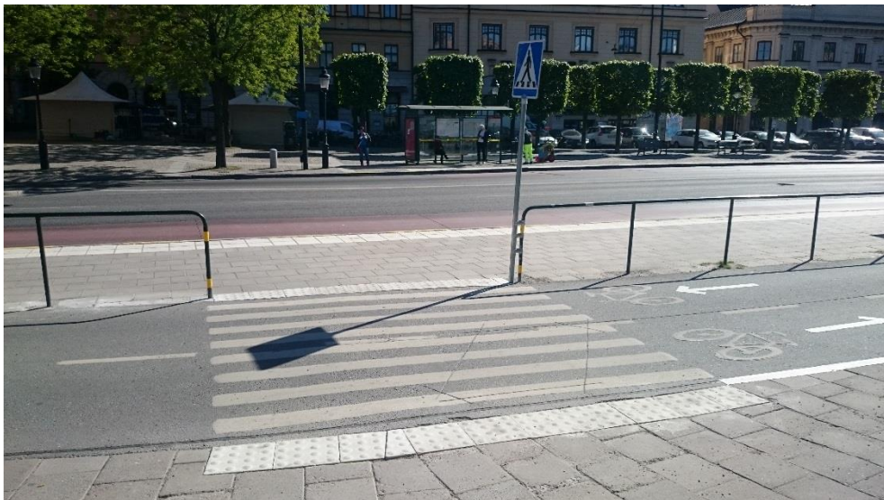
Figur 7-3 Gamla stan efter åtgärd (vägmärke Övergångsställe, vita kupolplattor på ömse sidor om övergångsstället, Cykelsymboler med riktningsspi- lar). Platsen är belägen vid bilkorsning samt busshållplats. Cykelbanan som är dubbelriktad är cirka 2 meter bred. Utformningen har sedan tidigare räcke och ett saxat övergångs- ställe.
