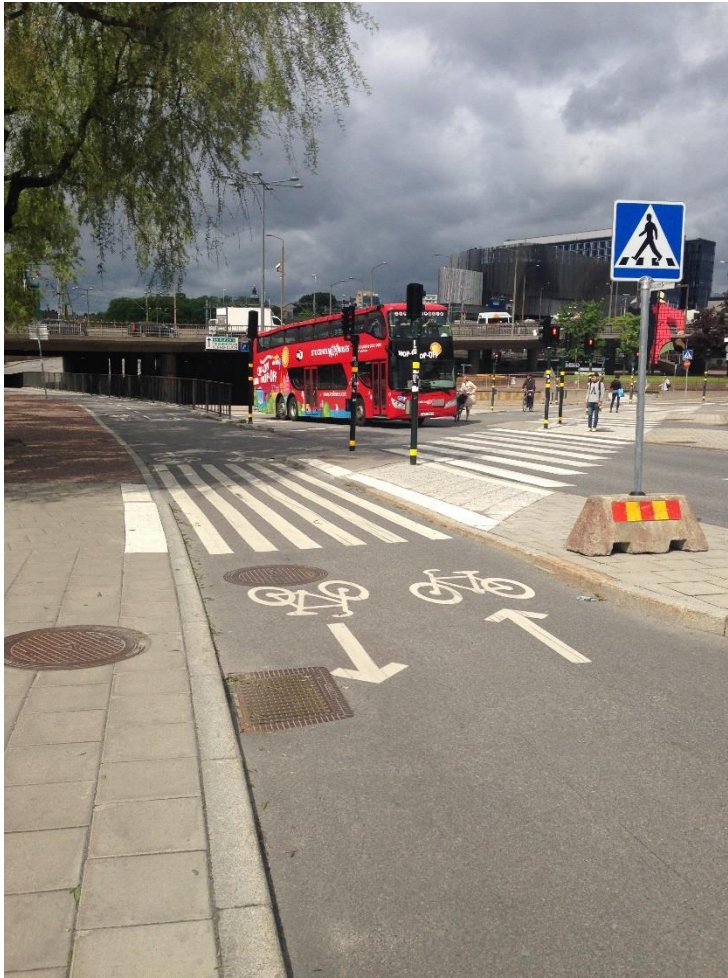
Figur 7-4 Tegelbacken efter åtgärd (vägmärke Övergångsställe, vita kupolplattor på ömse sidor om övergångsstället, cykelsymboler med riktningspilar). Platsen är belägen vid bilkorsning. Cykelbanan som är dubbelriktad är cirka 2,5 meter bred och ligger i lutning. Utformningen har sedan tidigare vägmarkering för övergångsställe.
