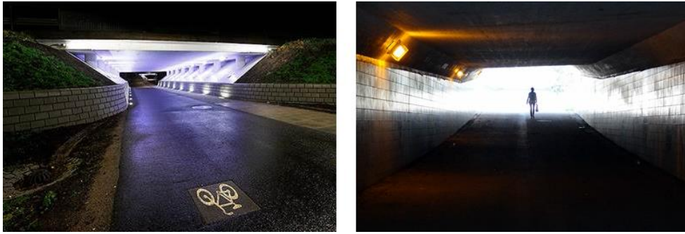
Figur 3-3. Exempel på bra och dålig utformning av tunnlar från Linköping (vänstra bilden) och Nacka (högra bilden). Bildkällor: www.tindradesign.nu och www.vikdalen.se
