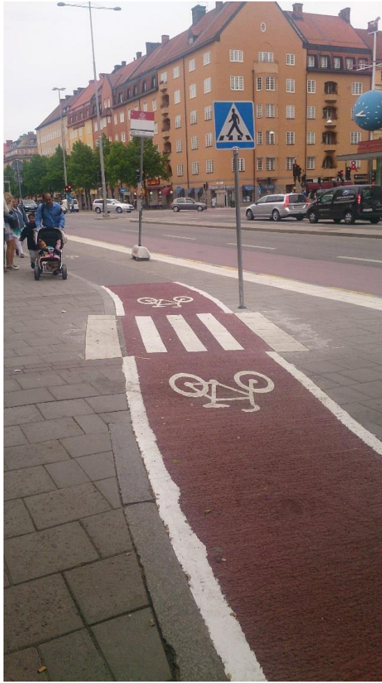
Figur 7-7 Skanstull efter åtgärd (rödfärgad beläggning, vägmarkering och vägmärke Övergångsställe, vita kupolplattor på ömse sidor om gångpassagen, cykelsymboler, vit heldragen linje mellan gång- och cykelyta). Platsen är belägen vid busshållplats. Cykelbanan som är enkelriktad är cirka 1,2 meter bred.
