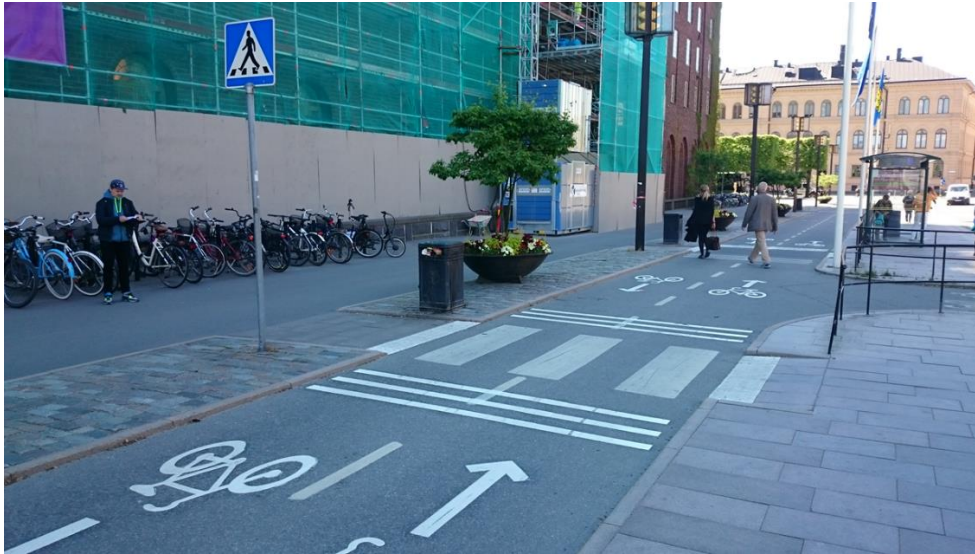
Figur 7-5 Stadshuset, efter åtgärd (vägmärke Övergångsställe, vita kupolplattor på ömse sidor om övergångsstället, cykelsymboler med riktningspilar, bullerremсор på ömse sidor om övergångsställe). Platsen är belägen vid bilkorsning samt busshållplats. Cykelbanan som är dubbelriktad är cirka 3 meter bred. Utformningen har sedan tidigare räckten och vägmärkning för övergångsställe.
