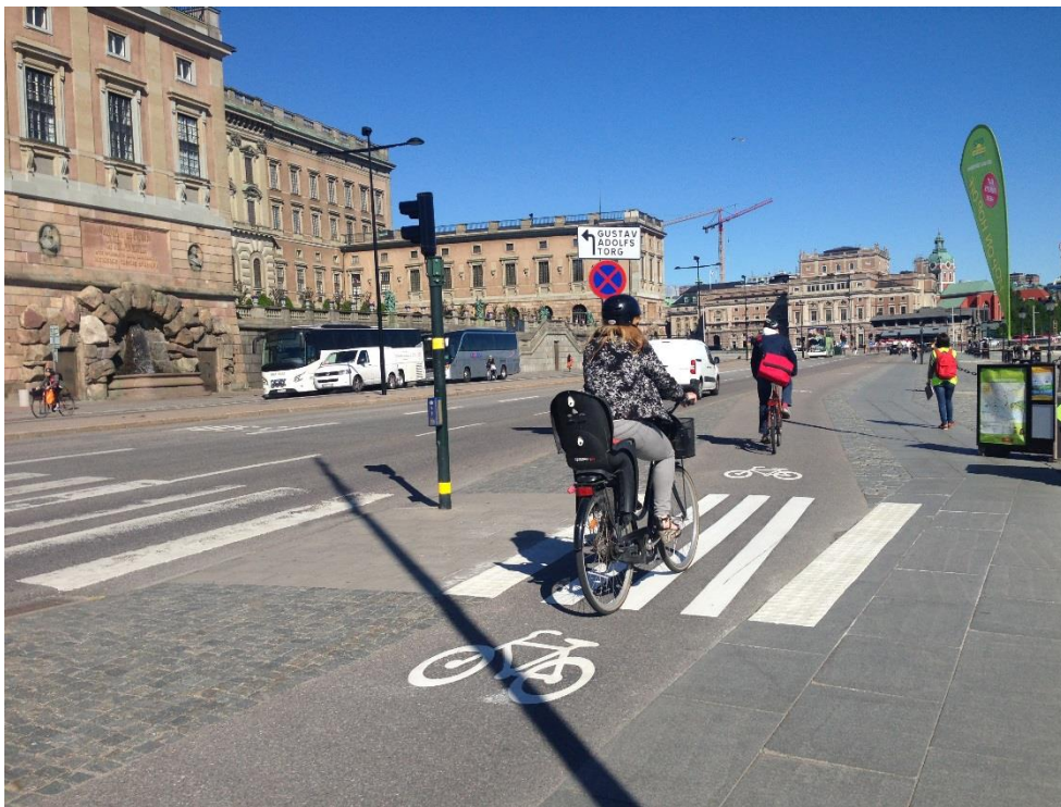
Figur 7-6 Skeppsbron efter åtgärd (vägmarkering Övergångsställe, vita kupolplattor på ömse sidor om gångpassagen, cykelsymboler). Platsen är belägen vid bilkorsning. Cykelbanan som är enkelriktad är cirka 1,2 meter bred.
