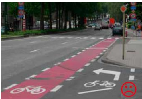
Cyklisterna kan inte se trafikljus. Här borde det finnas ytterligare ett trafikljus
