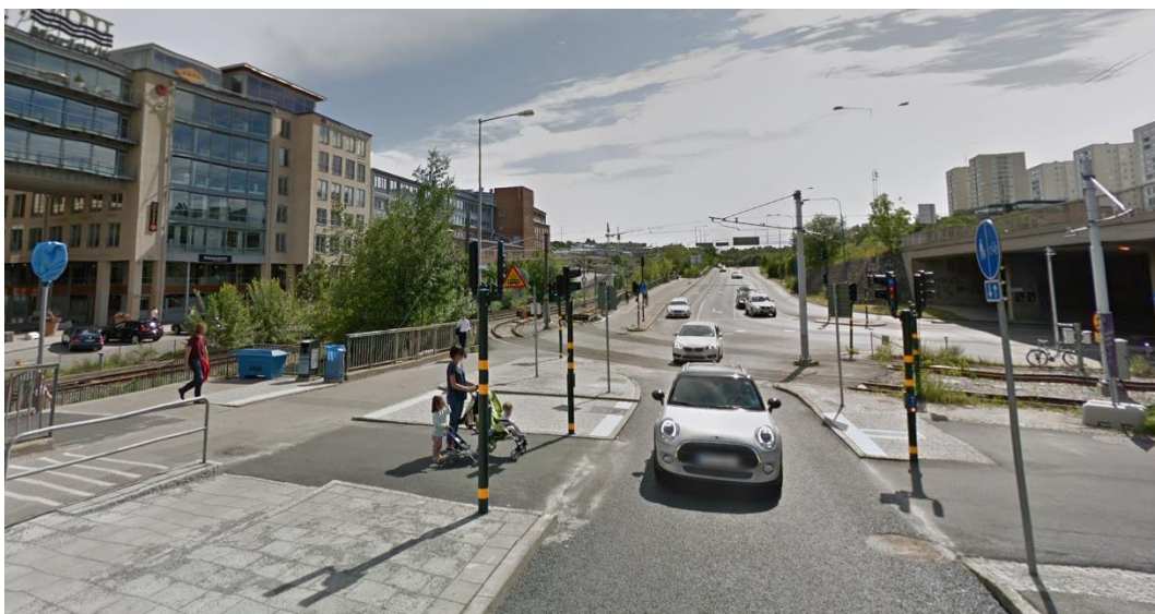
Figur 5. Efter ombyggnad. Källa: Google maps, 2017.
