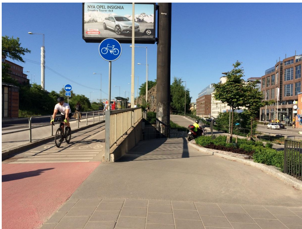
Figur 3. Busshållplats Marievik med ramper ned till passage över industrispår till höger. Cykelbana till vänster om räcket. Gångbana antingen via busshållplatsen längst till vänster i bild eller ner via rampen till höger.
