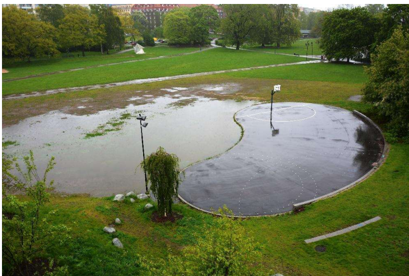
Bild 3: Skyfallsdamm i Rålambshovsparken
